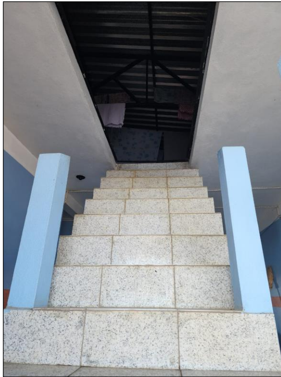
Acesso à laje de forro
