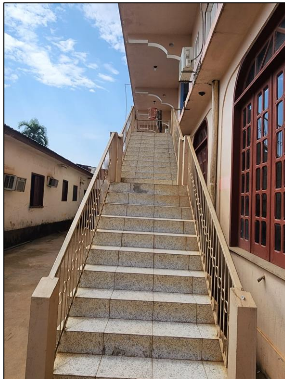
Escada de acesso ao 2º pavimento
