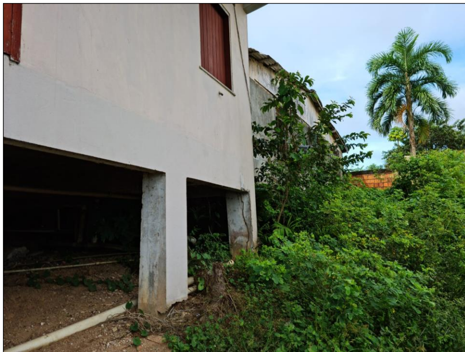
Estrutura do imóvel
