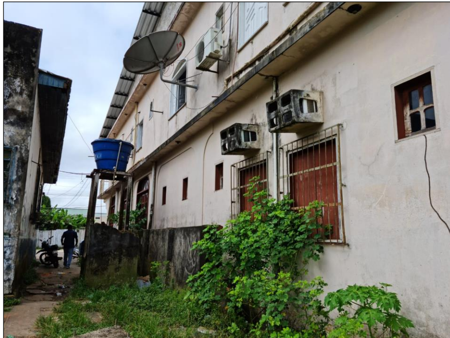
Lateral direita do imóvel
