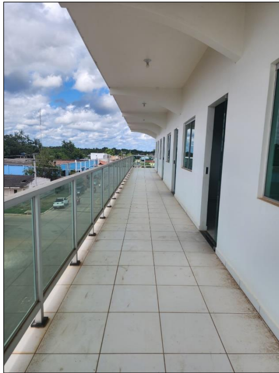
Corredor principal 2º pavimento
