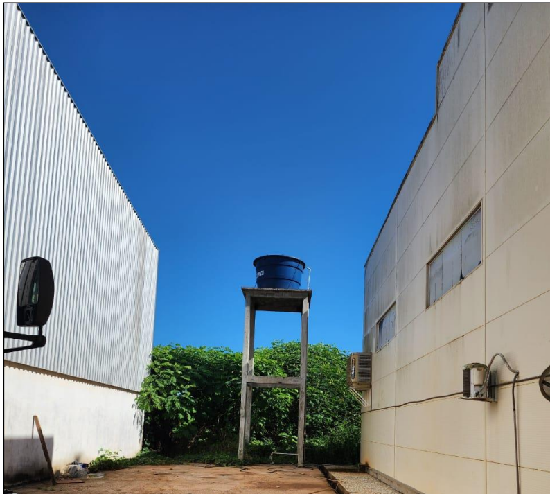
Reservatório de água
